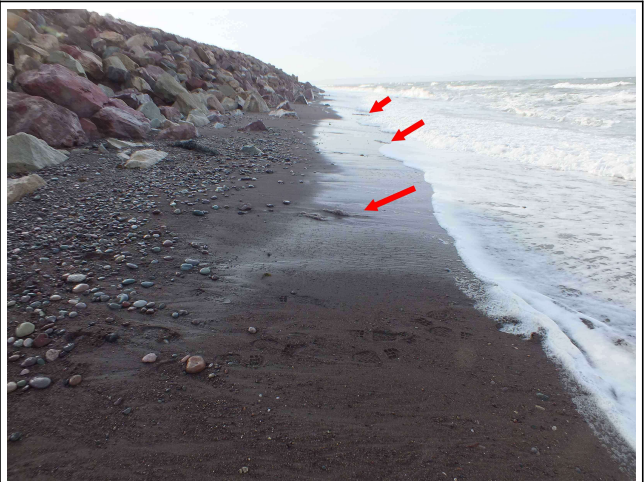
Géotextile du bas de l'enrochement descendu dans la plage
