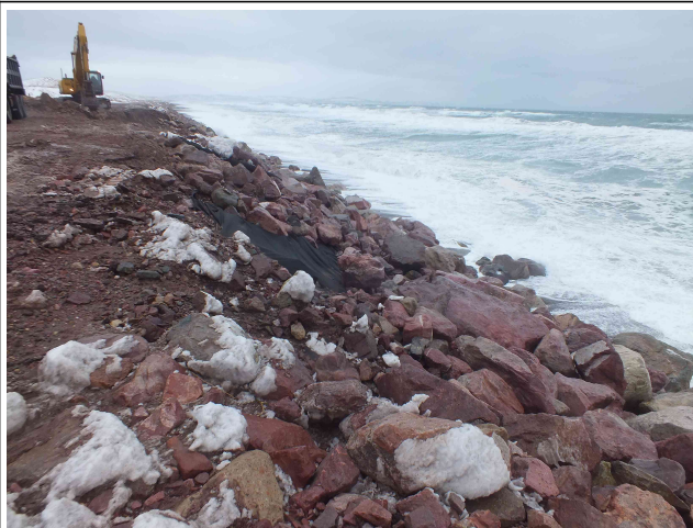
Géotextile en partie aval le 6 mars
