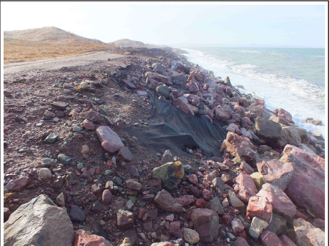
Géotextile en partie aval le 22 mars
